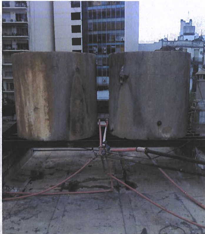
REF 1) SECTOR LAVADERO
